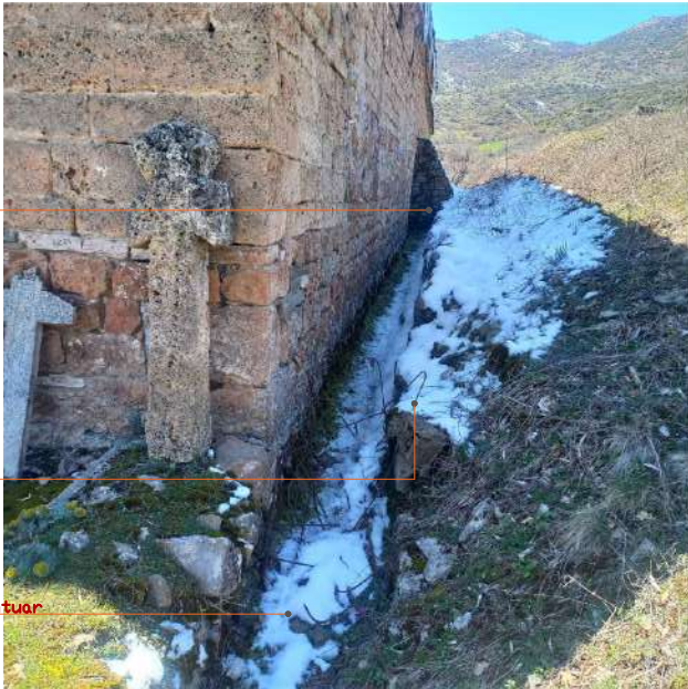
Carje siperfaqesore ne strukturen e gurit Dentim i brezave te drurit
