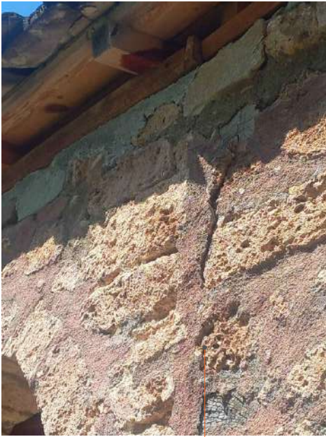
Carje siperfaqesore ne strukturen e gurit Dentim i brezave te drurit
